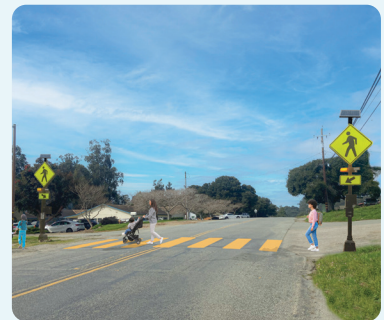
Señales rectangulares de luces intermitentes en el cruce peatonal cerca de Prunedale Elementary School
