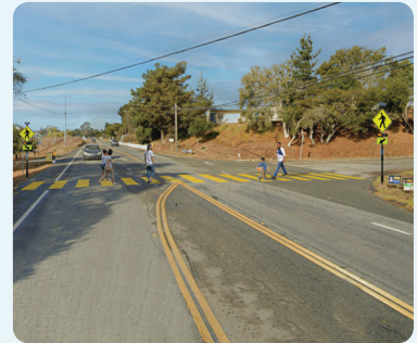
Señales rectangulares de luces intermitentes en el cruce peatonal en Hall Road y Sill Road
