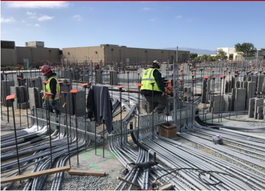
Under Slab Conduits
