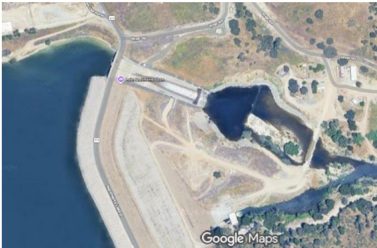
Figure 3: Nacimiento Dam Spillway Plunge Pool
