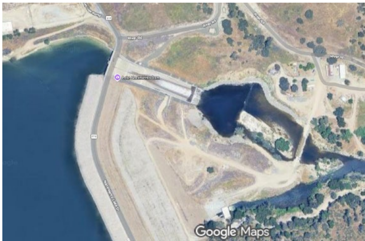
Figure 3: Nacimiento Dam Spillway Plunge Pool
