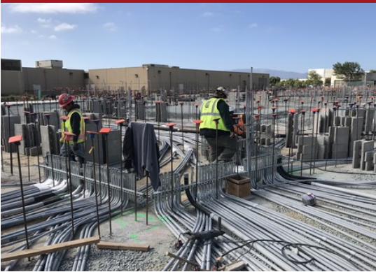
Under Slab Conduits
