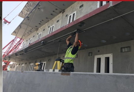
Conduits in Precast Chase
