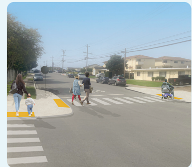
Extensiones de acera y cruces peatonales de alta visibilidad en la intersección de Preston Street y Geil Street
